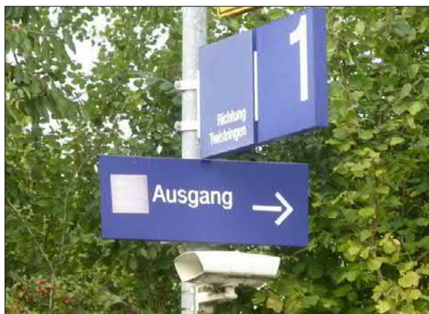
Abb. 28: In Bramstedt sind die Piktogramme für Schienenersatzverkehr auf den Wegeleitungsschildern verblasst. Schäden in dieser oder anderer Form sind an den SEV-Piktogrammen in der Wegeleitung relativ häufig zu beobachten.
