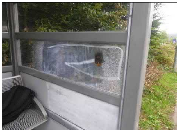
Abb. 59: Der Ersatz von Glas- durch Kunststoffscheiben ist nicht nur bei Vitrinen, sondern auch in Unterständen nicht immer von Vorteil. Diese Scheibe in Großenkneten ist flächig zerkratzt und angeschmort
