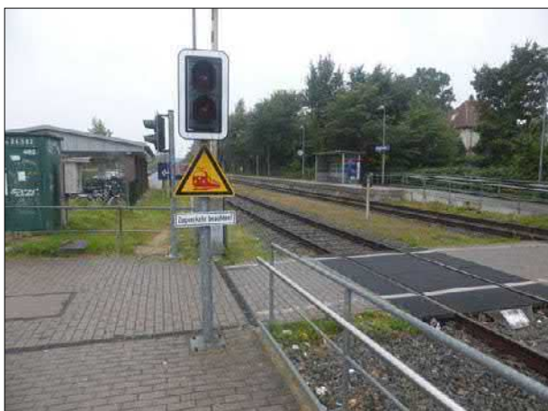
Abb. 45: An der Rampe vom Bahnsteig an Gleis 1 zum Gleisüberweg in Wildeshausen führt der rechte Handlauf direkt auf den Mast der technischen Sicherung.
