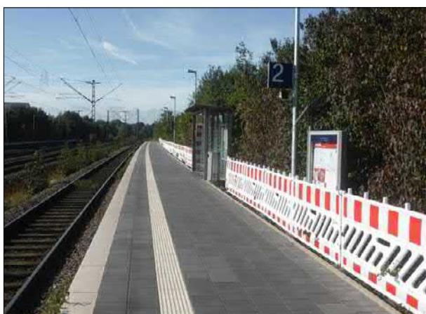
Abb. 2: In Lemförde wurden die Bahnsteige für den bevorstehenden Einsatz neuer Fahrzeuge etwas aufgehöhht. Die Oberflächen wurden mit Integration eines Blindenleittreifens neu gepflastert.
