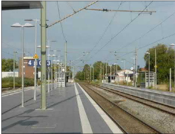
Abb. 7: Die Bahnsteige in Westerstede-Ocholt wurden erneuert. Dabei wurden die Bahnsteighöhe für barrierefreien Zugestieg angehoben und in der Pflasterung ein Blindenleitsystem angelegt.
