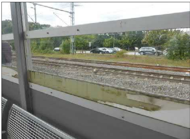
Abb. 52: An einigen Stationen wurden an den Unterständen und Einhausungen vor mehreren Jahren nachträglich Sicherheitsbeklebungen angebracht. Mittlerweile lösen sich diese teilweise ab und sind verschmutzt, so dass das Erscheinungsbild, wie hier in Barnstorf, beeinträchtigt wird.
