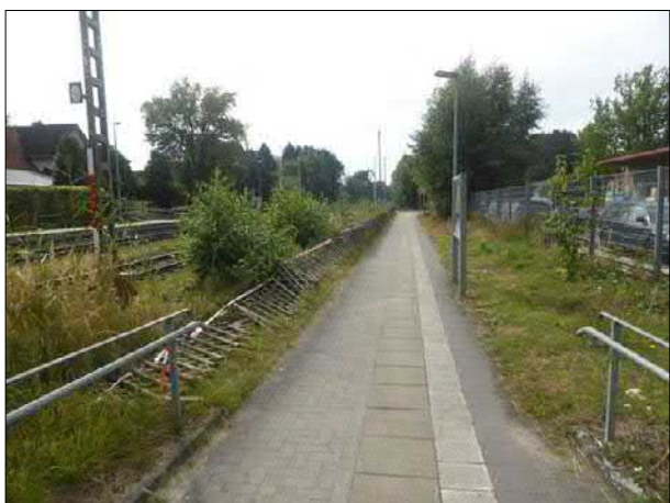
Abb. 54: In Huntlosen war der Zaun entlang der Zuwegung zu Gleis 2 an der Gleisseite auf größerer Länge umgestürzt.
