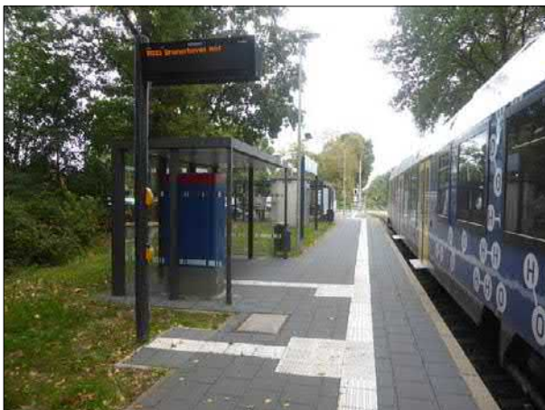
Abb. 6: Der Bahnsteig in Sellstedt wurde vor dem Zugzielanzeiger um eine Plattenreihe verbreitert. Dadurch ist der Taster für die Anforderung der akustischen Information ohne Stolperfalle erreichbar.
