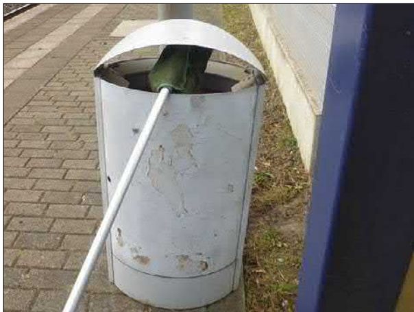
Abb. 20: In Dörverden wurden die Lackschäden an einigen Mülleimern übergestrichen. Schon nach kurzer Zeit ist jedoch schon wieder Rost sichtbar.
