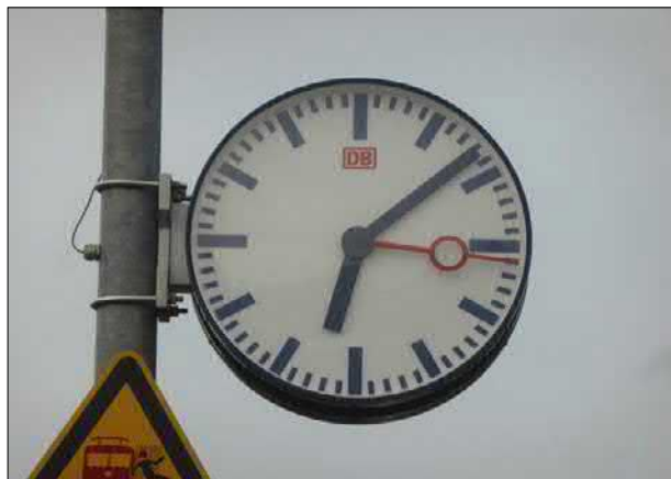
Abb. 25: In Barrien waren die Zeiger der Uhren an beiden Bahnsteigen jeweils einseitig etwas verdreht, so dass nicht die korrekte Zeit angezeigt wurde.
