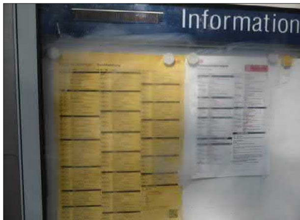
Abb. 31: In Bookholzberg waren die Fahrplanaushänge bereichsweise nicht lesbar, da die Vitrinenscheiben aus Kunststoff flächig zerkratzt waren.
