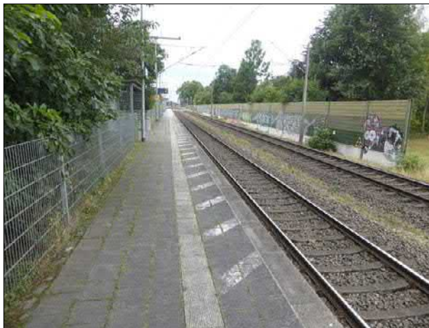
Abb. 8: In Wüstring an Gleis 2 ist der Kontrast zwischen dem Blindenleitstreifen und den anderen Bahnsteigplatten durch Verschmutzung deutlich reduziert.
