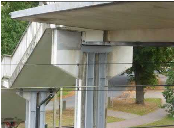
Abb. 5: Die Stützen der nur über Treppen nutzbaren Brücke zwischen den Bahnsteigen in Barrien wurden in letzter Zeit durch Eisenträger verstärkt.
