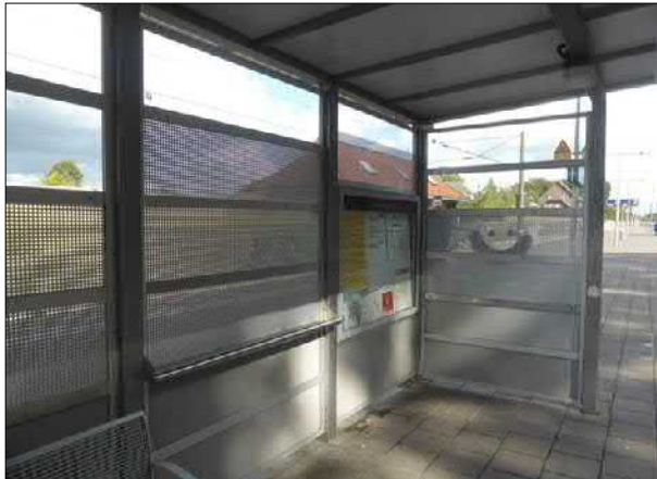
Abb. 16: Im Unterstand von Bookholzberg wurden viele Scheiben mit Lochblechen verkleidet, um Zerstörungen zu verhindern. Die Aufenthaltsqualität wird durch die verringerte Aussicht und Einsehbarkeit jedoch reduziert.
