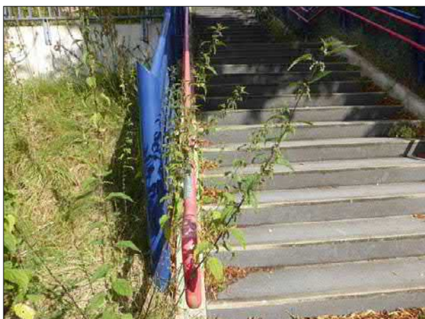
Abb. 41: In Stubben wucherten Brennnessel und andere Pflanzen auf die Treppe und über den Handlauf von Gleis 1 auf die Brücke. Betroffen waren auch die taktilen Wegeleitungsschilder.
